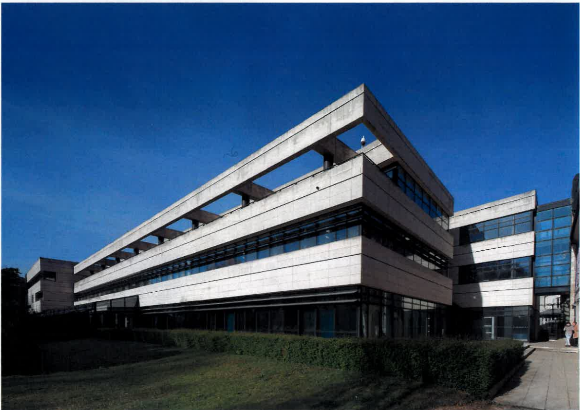
Façade postérieure sur le jardin, vue actuelle © LMDP / Sébastien Andréi
