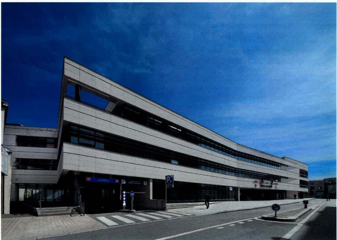
Façade de l'extension longeant la rue Jacques-Rimbault, vue actuelle © LMDP / Sébastien Andréi
