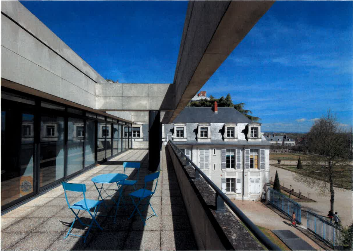
Terrasse du 3 e niveau, vue actuelle © LMDP / Sébastien Andréi
