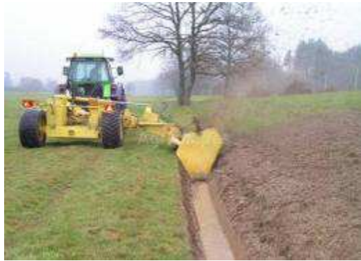
Figure 3 : Exemples de curage et reprofilage de fossé
