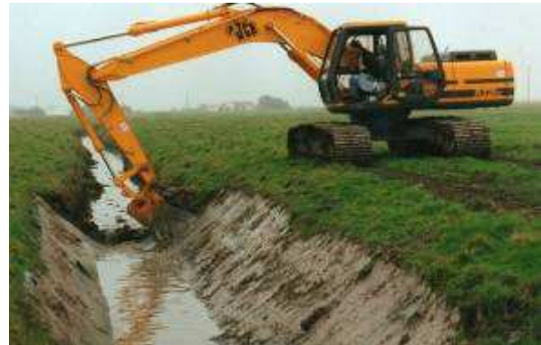
Figure 3 : Exemples de curage et reprofilage de fossé
