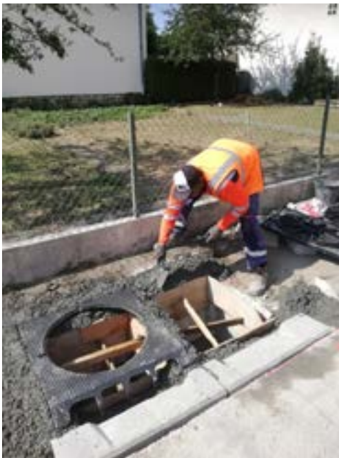
Travaux de maçonnerie - modernisation des avaloirs
