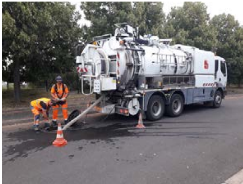
Opération de curage/pompage réseau pluvial
