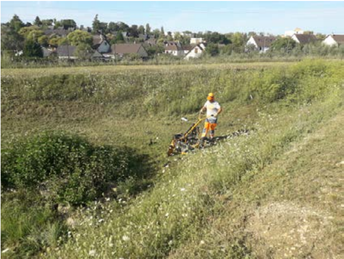
Entretien de bassin de rétention à ciel ouvert - travaux de débroussaillage
