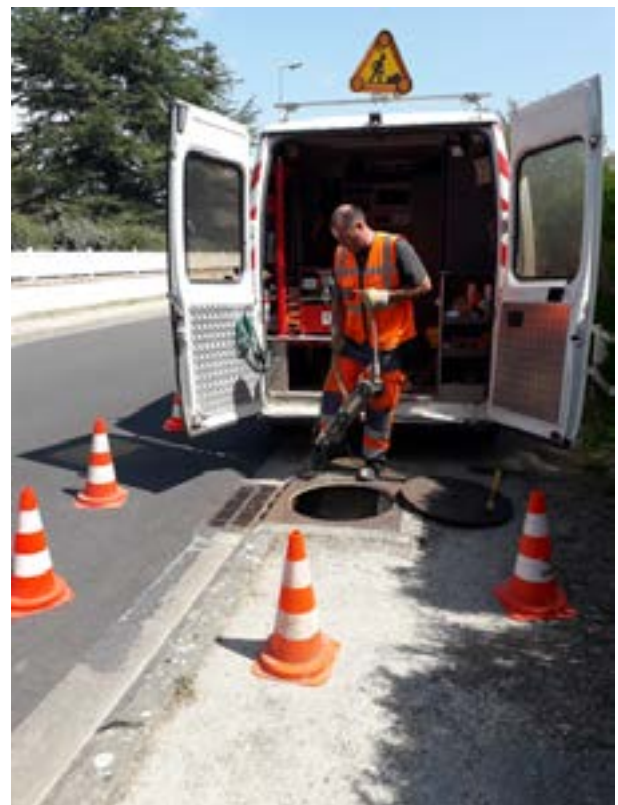
Travaux d'inspection télévisée - réseau pluvial
