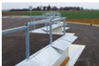
Garde-corps et bavettes de vidage telles qu'elles apparaissent à la déchèterie des Quatre Vents
