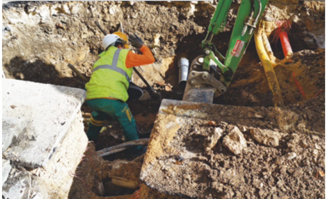
> L'enchevêtrement des réseaux peut rendre un chantier délicat (ici avenue de Peterborough à Bourges).
