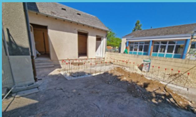
Travaux pour la mise en accessibilité des sanitaires de l'école élémentaire de Marmagne
