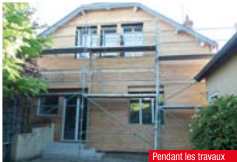
Pendant les travaux
