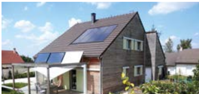
À Saint-Doulchard, exemple d'une maison proche des performances passives.
