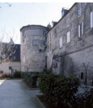
1/Bâtiments médiévaux et modernes fondés sur le mur du castrum du Bas-Empire.
