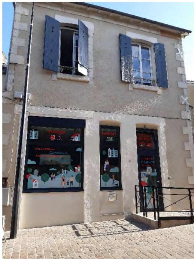
La Maison de l'Habitat et du Cœur de Ville située 4 Cours Avaricum à Bourges : 2684 contacts traités
