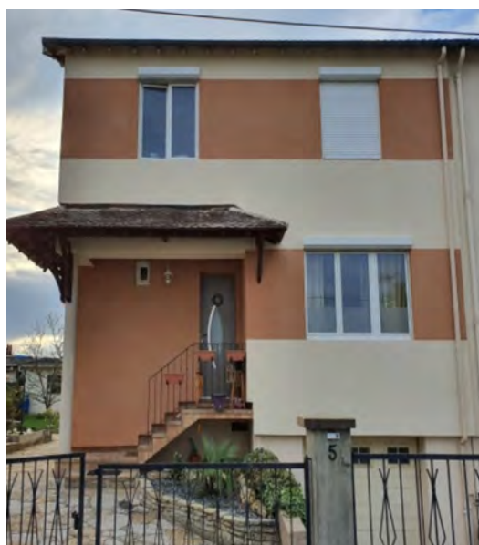
1 er projet BBC avant/après travaux
