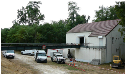
Figure 38 : Travaux à la station d'Herry
