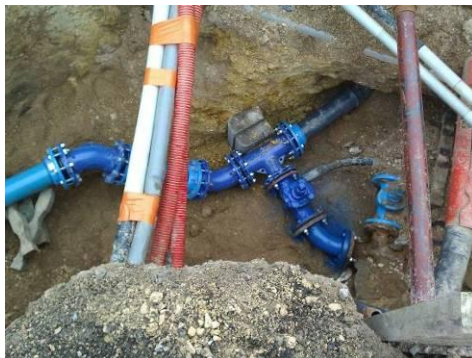
Figure 52 : Travaux de raccordement sur la Route de Bourges (La Chapelle Saint-Ursin)
