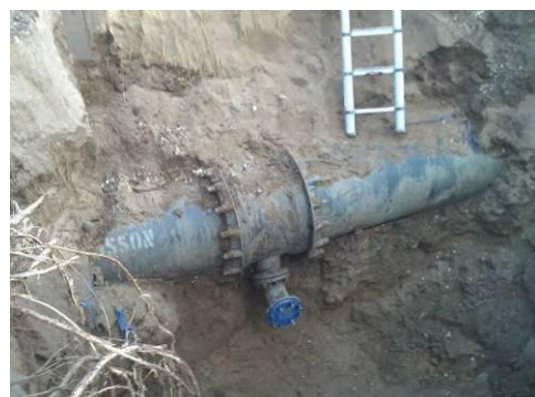
Figure 53 : Travaux de modification de vidanges sur la conduite d'Herry en amont du canal latéral à la Loire
