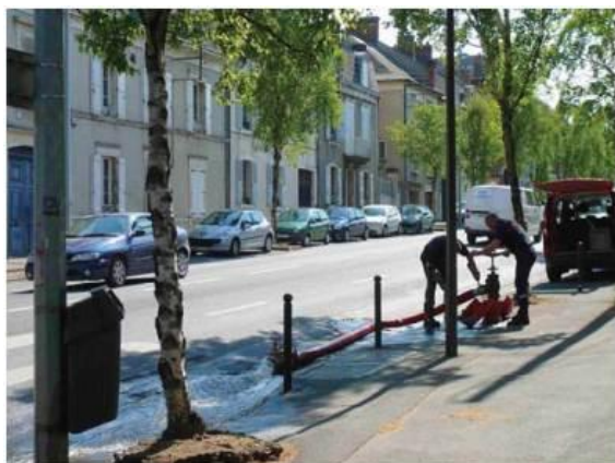
Figure 37 : Pesée d'un hydrant par le service départemental d'incendie et de secours
