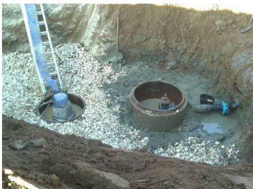
Figure 53 : Travaux de modification de vidanges sur la conduite d'Herry en amont du canal latéral à la Loire
