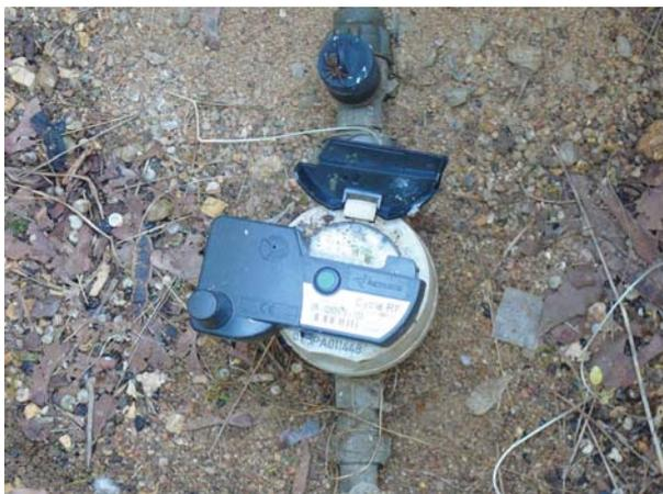
**Figure 11 :** Module radio sur compteur
