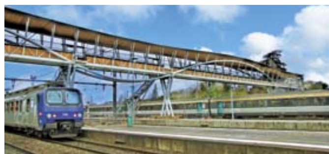
La passerelle de la Gare, réalisée par l'Agglo, profite à tous les habitants de Bourges Plus
