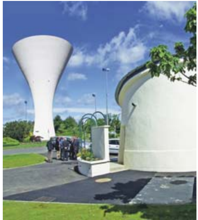
Le Château d'eau de Saint-Doulchard
