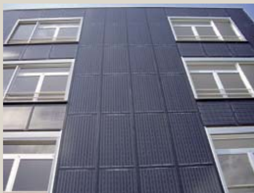
Façade recouverte de panneaux photovoltaïques
